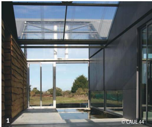
1-La MW, Ken en So architectes. un jardin d'hiver (tempéré par les apports solaires et la ventilation) avec un bassin sert d'espace tampon et de desserte des pièces de vie.
