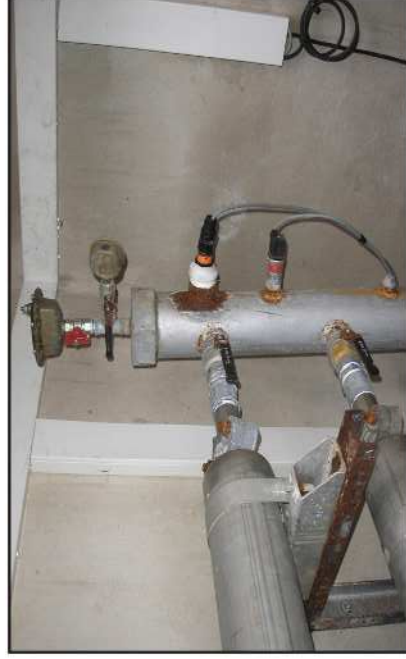
Ventouse et les deux modules de surpression
