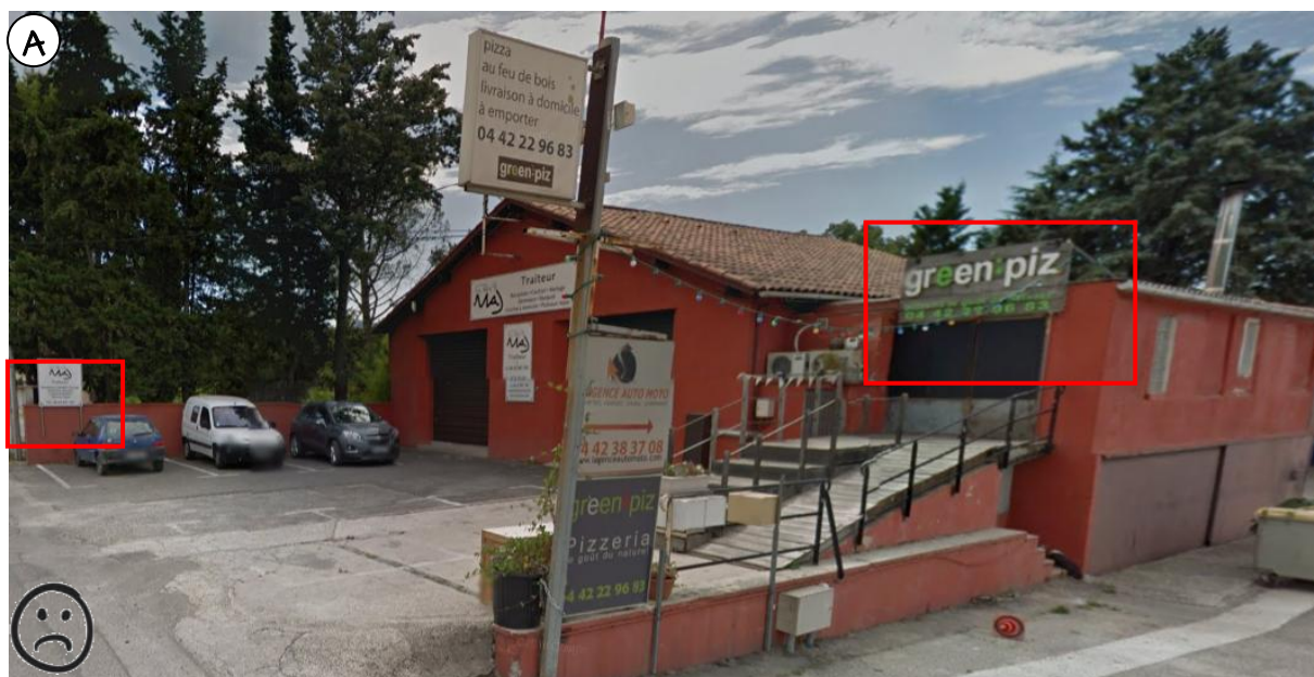
Bâtiment commercial à l'intersection avec la RD60.
