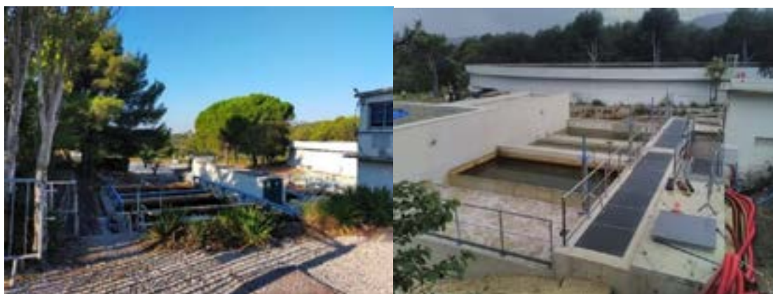
Ancien filtres / nouveaux filtres – Usine de production d'eau potable de Cassis
